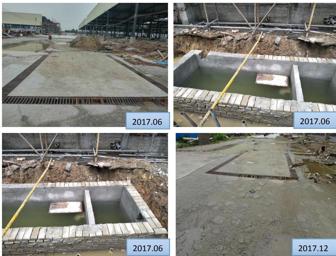
图 3-3 水土保持临时措施照片
