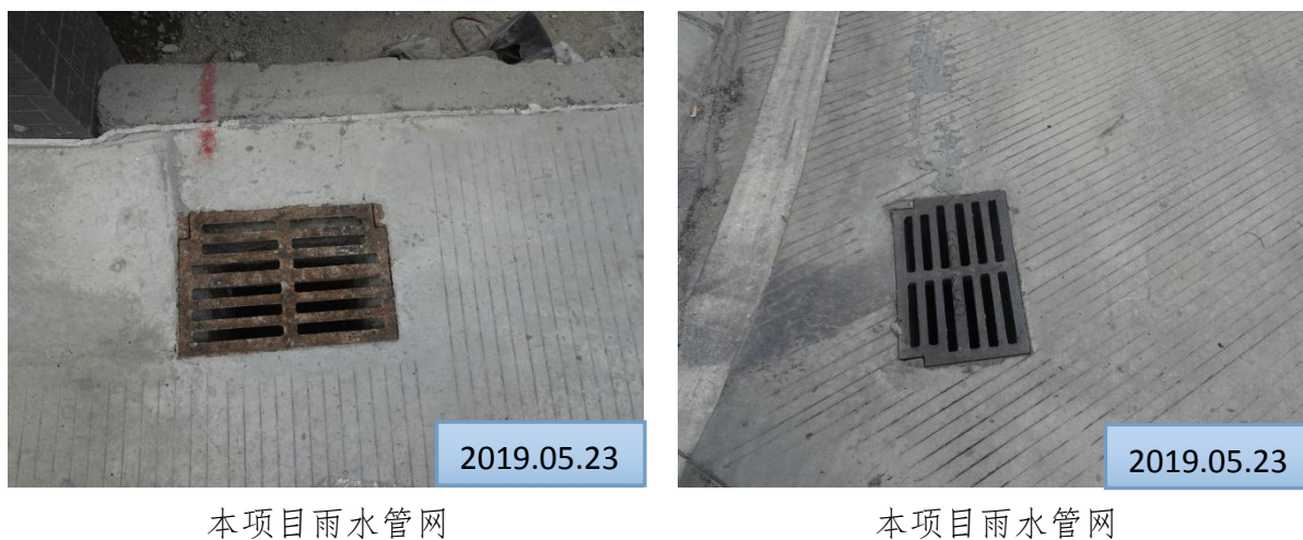
图 3-1 水土保持工程措施照片
